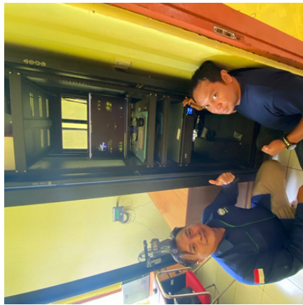
16/12/2024 - Teknisi Stamet UMK melakukan penggantian sistem komunikasi data dari site ke server dan melakukan pemasangan UPS pada server AWOS (Automatic Weather Observing System) di Pos Meteorologi Tambolaka.
